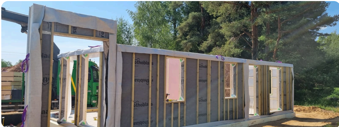
Montagem dos painéis em obra · obra de referência da fábrica
