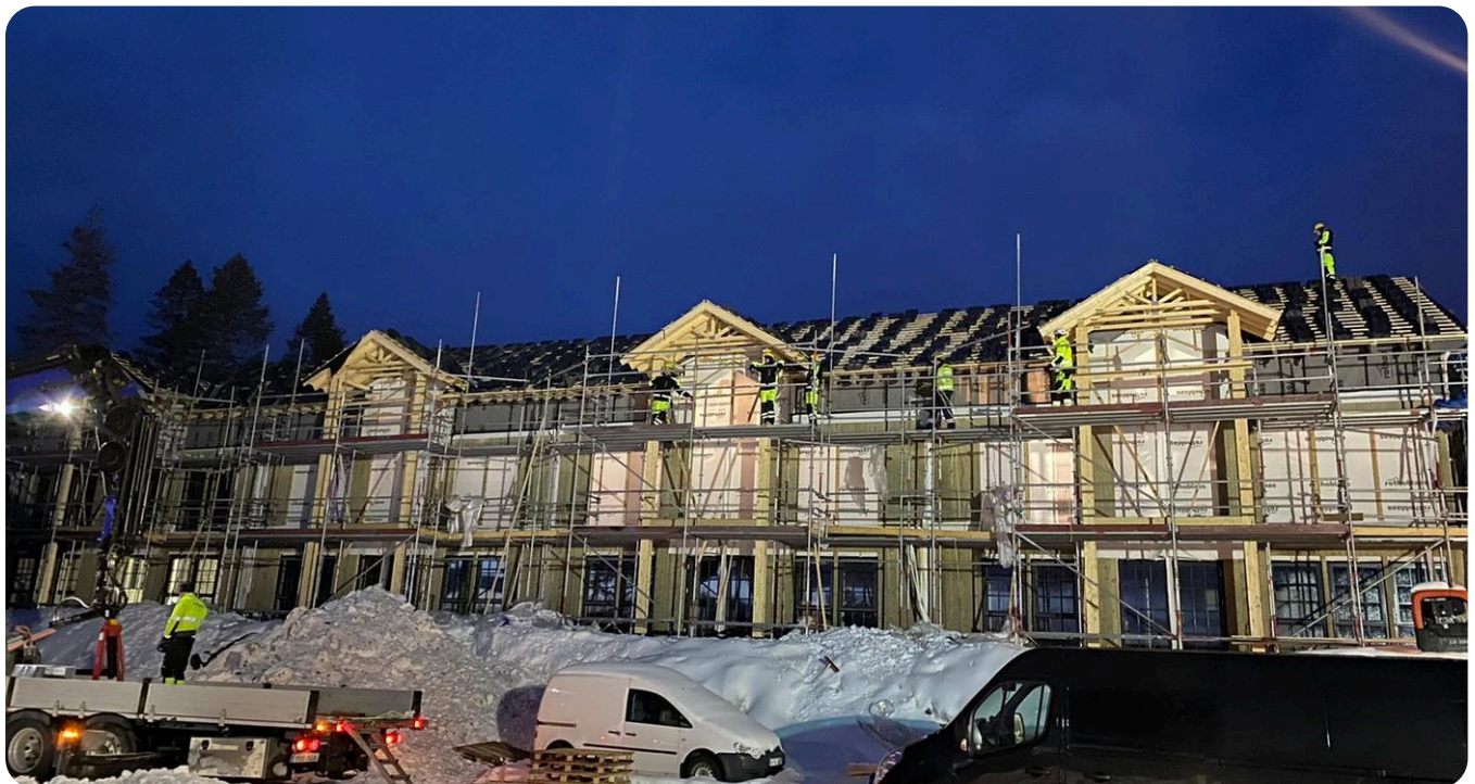
Idre, Suécia · obra de referência da fábrica, em montagem
