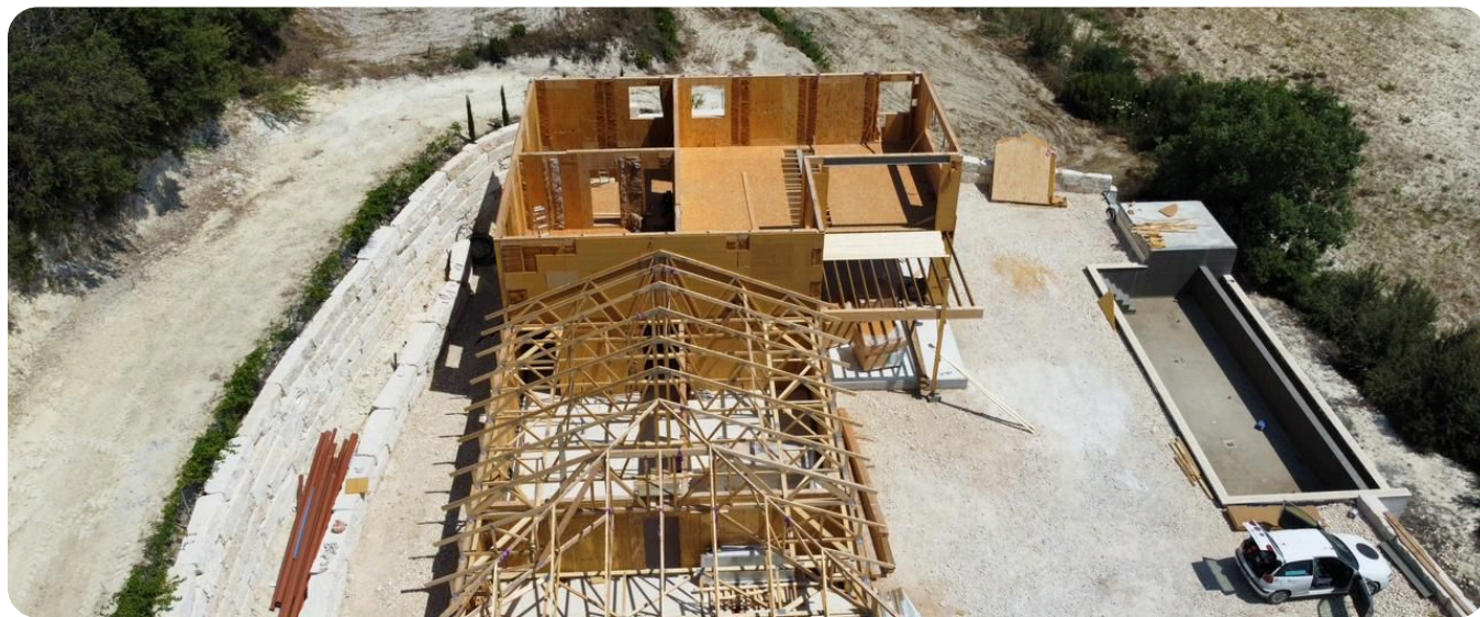
Estrutura em montagem, Chipre · obra de referência da fábrica
