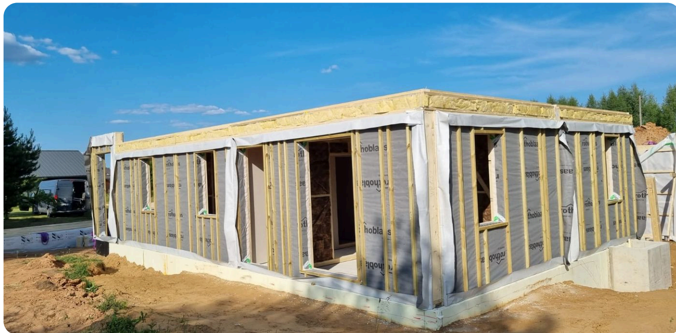
Estrutura montada em obra · obra de referência da fábrica, Letónia
