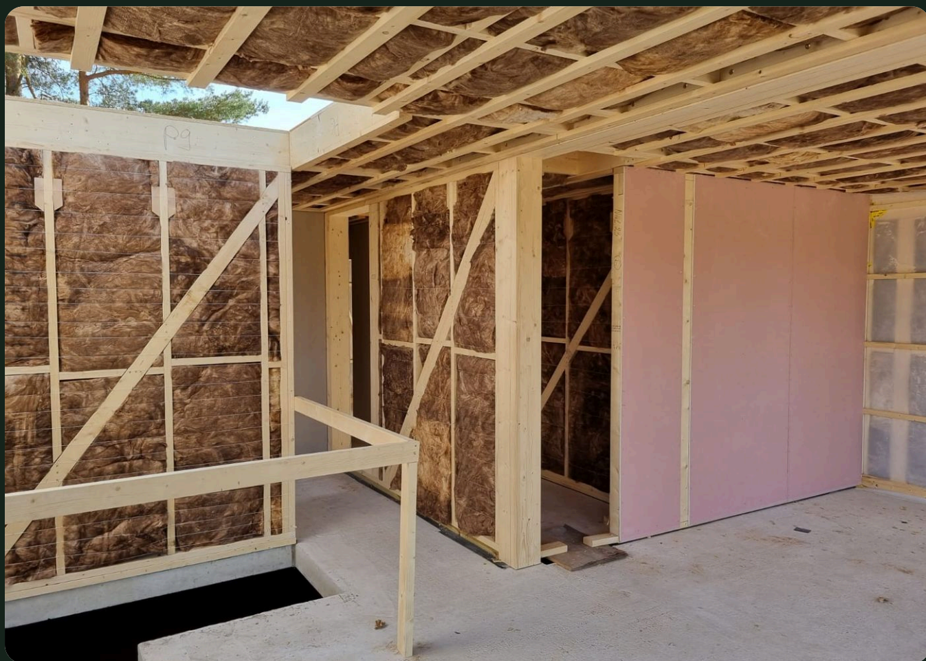
Painéis montados em obra, antes dos acabamentos interiores · obra de referência da fábrica, Letónia
