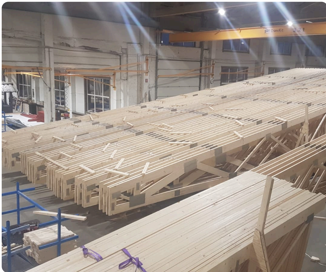
Asnas de cobertura empilhadas na nave da fábrica.
